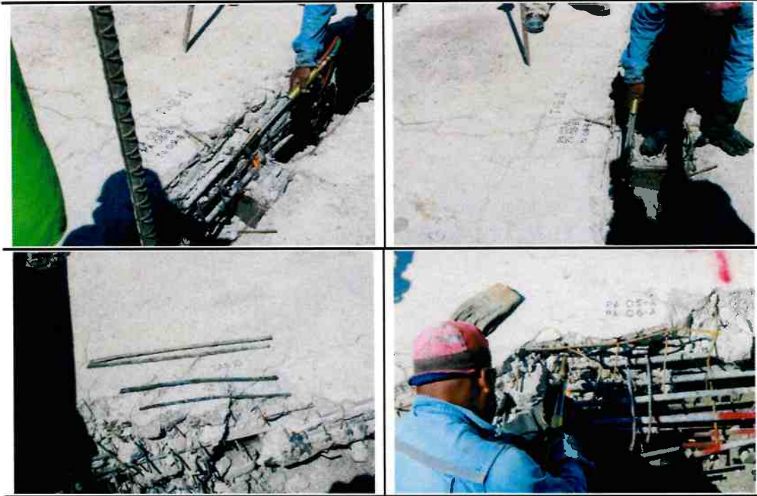
Extracción y corte de muestras de acero en el almacén de Tláhuac
