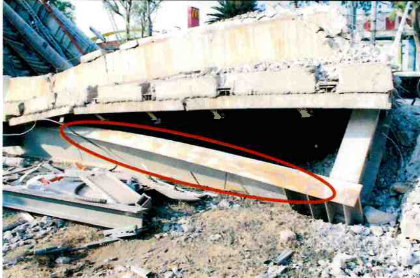
Evidencia que el número de Pemos Nelson en la trabe T-6 no coinciden con los indicados en los planos de diseño
