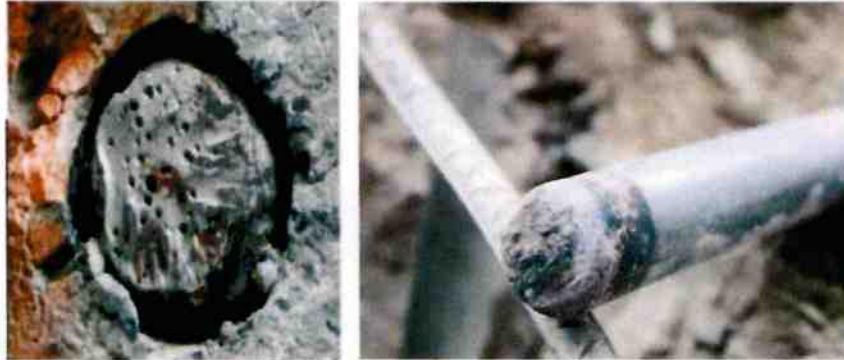
Figura IV.1.8 – Detalle de los pernos Nelson
