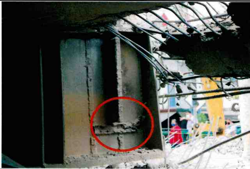
Figura IV.1.3- Conexión trabe T-3-trabe puente- trabe T-6
