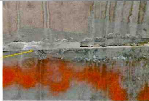
Figura IV.1.17 Detalles de resanes de concreto en tableta de losa prefabricada
