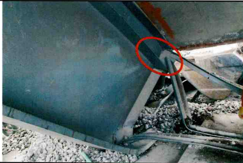
Vista general de trabe T-1 – contraventeo CV-1
