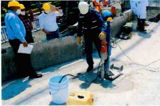
Instalación del equipo extractor de núcleos
