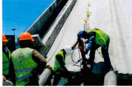
Progreso de la extracción de núcleos de concreto
