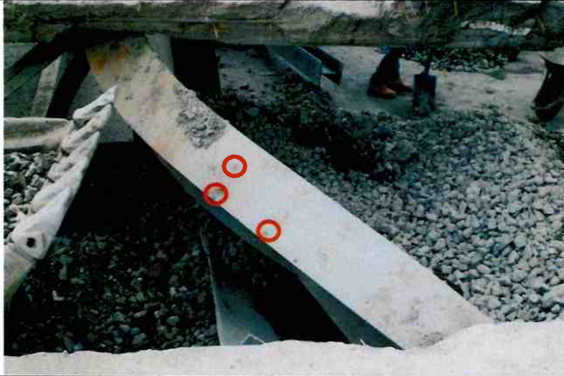
Evidencia que el número de Pemos Nelson en la trabe T-1 no coinciden con los indicados en los planos de diseño
