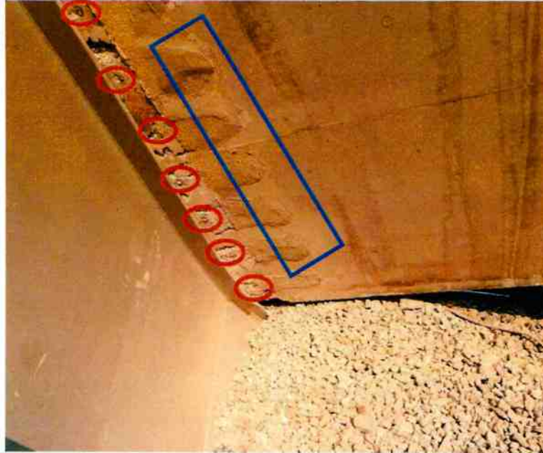
Figura IV.1.7 – Detalle de los pernos Nelson
